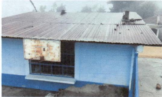
Foto1: Modulo de cocina.sustitución de lamina por lamina troquelada
