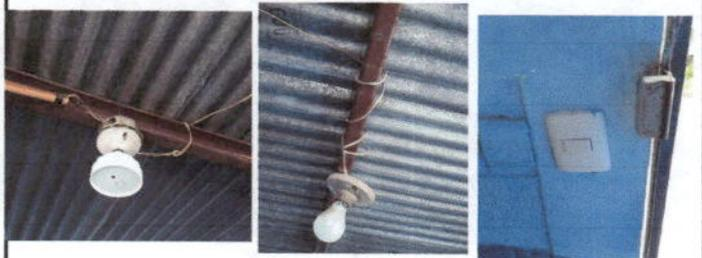
Foto 6 : sistema electrico módulo de cocina sustitucion de cocos ahorradores, plafoneras, inteterruptores dobles, tomacorrientes dobles, cableado electrico, conducto eléctrico+accesorios. Sustitución por mala
