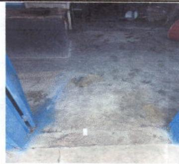
Foto 4: sustitución piso de torta de concreto en mal estado por, modulo de cocina
