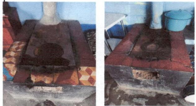
Foto: estufas, en en mal estado, oxidado, planchas endidas
