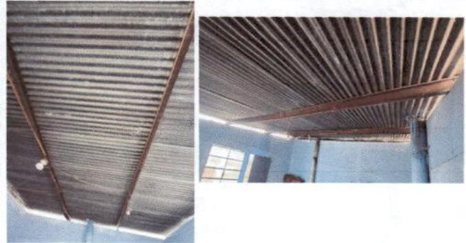
Foto 2: estructura de techo cocina sustitucion de soporte de metal por metal
