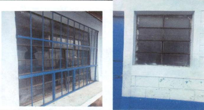
Foto 3: sustitución de estructura de metal de ventana, con oxido y vidrios quebrados, por ventana por (pvc). En modulo de cocina
